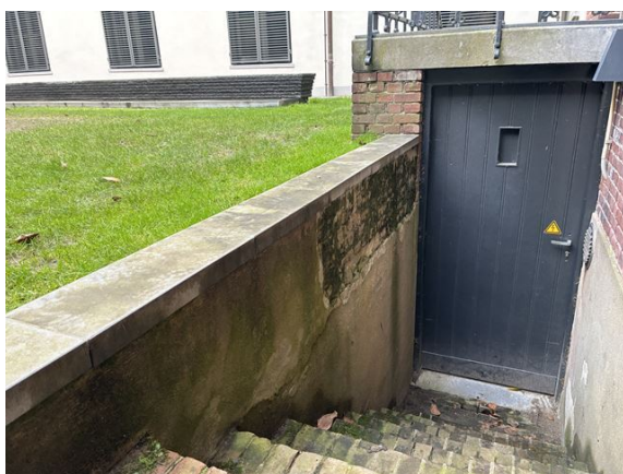
buitenruimte no. 5: buitenpleisterwerk plaatselijk verwijderd (2025)
