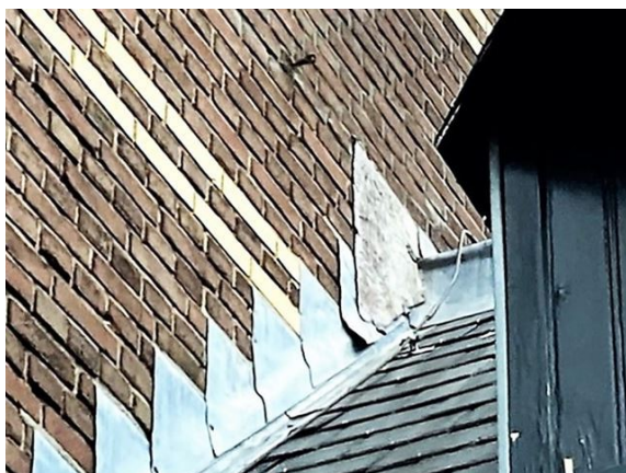
dak no. 11-12: gescheurde loket tijdelijk met kit gefixeerd (2022)
