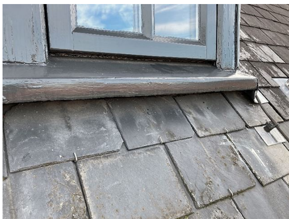
dak no. 1: leien in het zicht vernageld (2023)
