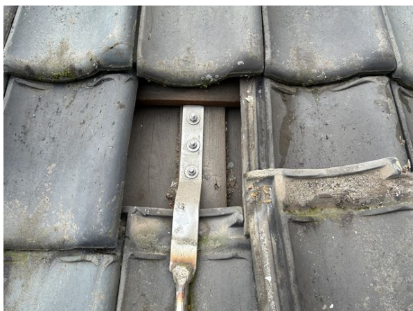
dak no. 20: gecertificeerde dakhaak met M8 bouten en moeren bevestigd (2025)
