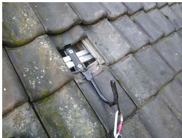
dak no. 18 t/m 21: situatie geplaatste ankerpunten (2019)
