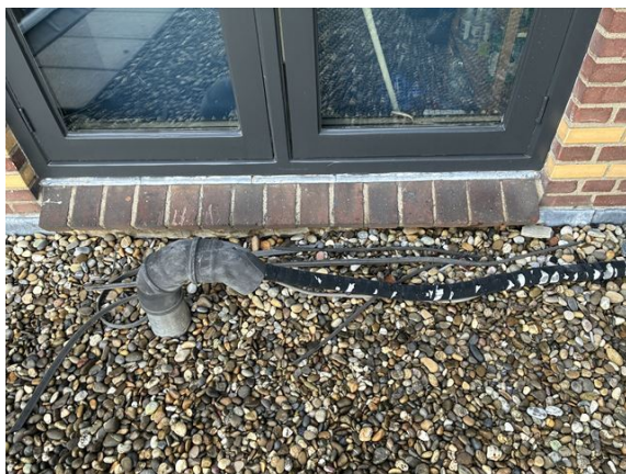
gevel no. 3: gedemonteerde tochtstrips op dak no. 16 (2025)
