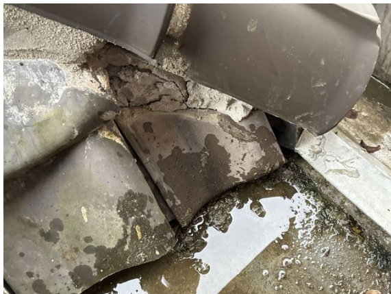
dak no. 21: speciezoom niet afgewerkt (2025)
