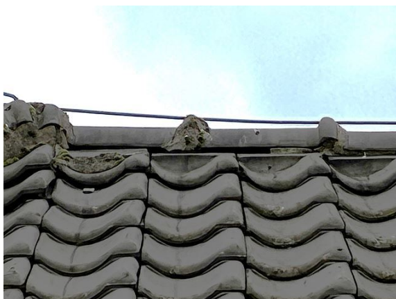
dak no. 20: speciezomen weggevallen (2024)
