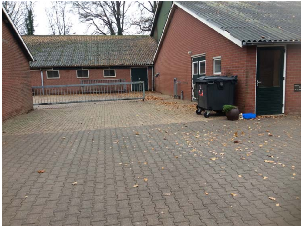
Locaties B en F; Multibox tbv zuuropslag + Luchtwater en spuiwater
