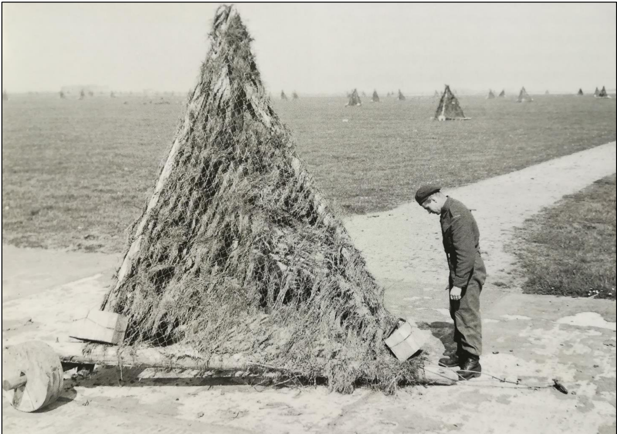
Figuur 28. Nadat de Luftwaffe in april 1945 het vliegveld verlaten had lieten zij voor de Canadese bevrijders veel versperringen waaronder tetraëders. Deze moesten vijandelijke landingen op het vliegveld verhinderen. Bron: Library and Archives Canada.
