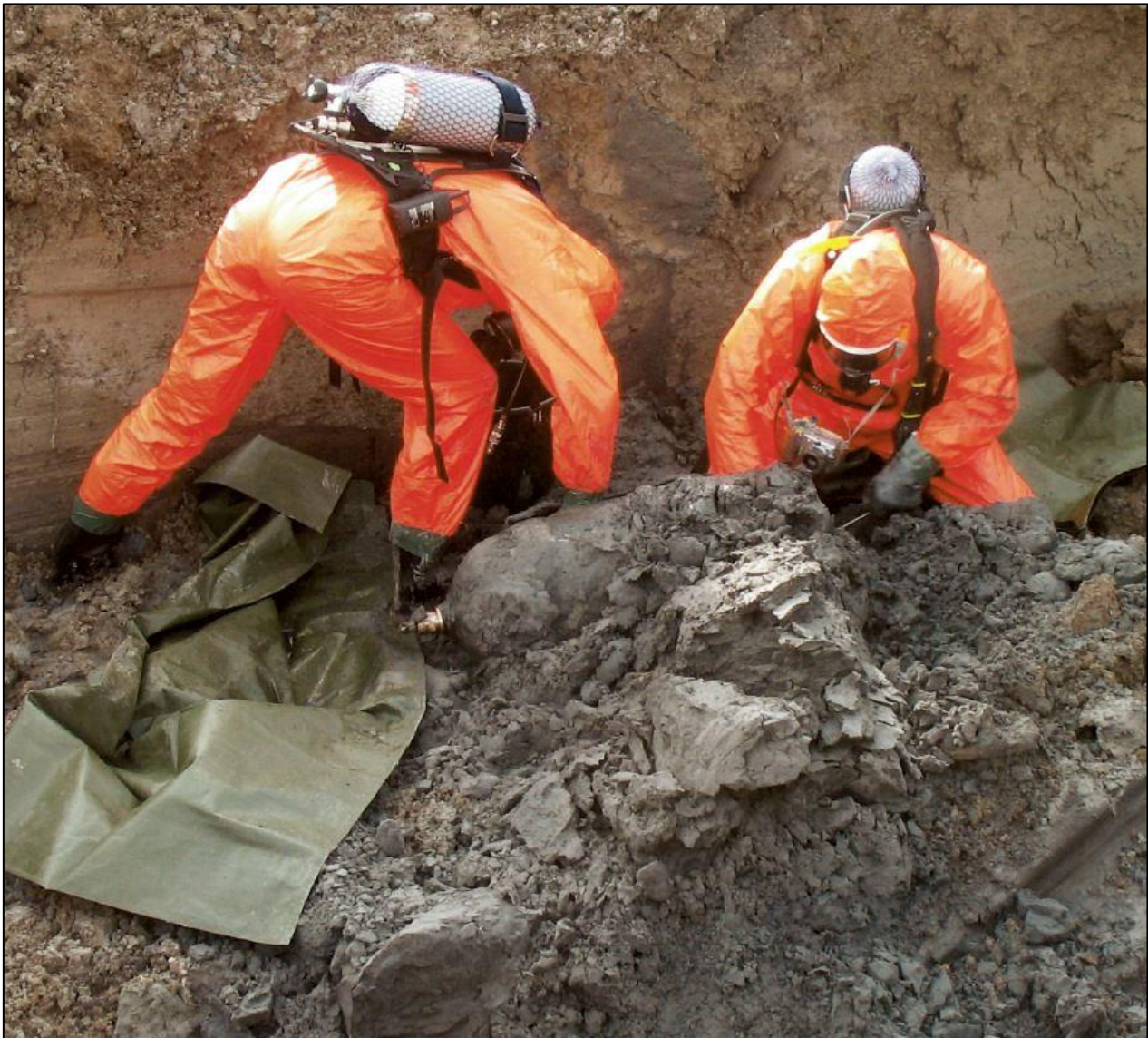
Figuur 29. Op 12 maart 2011 ruimde de EOD op vliegbasis Leeuwarden twee brandbommen van 250 lb. Mark II. Omdat de bommen de giftige stof Tolueen bevatte moest er beschermende kleding gedragen worden. Bron: de Bombardon nr. 2 (2011).
