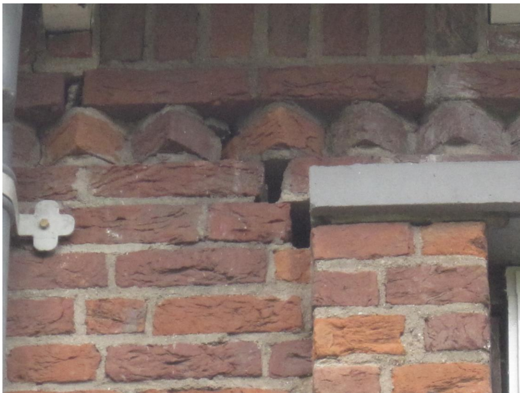
Figuur 3.2 Locatie K46 met open stootvoegen.
