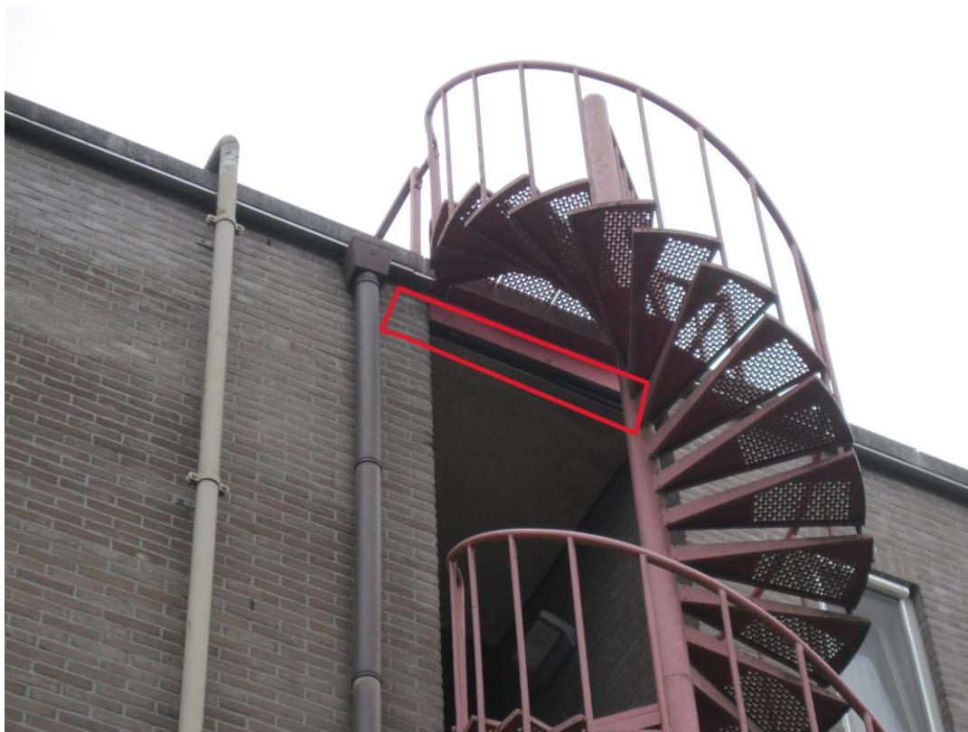
Figuur 3.3 Locatie K90 met boven de brandtrap een ruimte met potentiële verblijfplaatsen voor vleermuizen (rode omlijning). Bron: Ecogroen.
