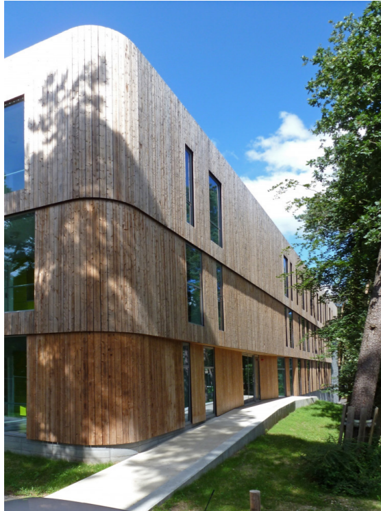
Overhangende geveldelen
