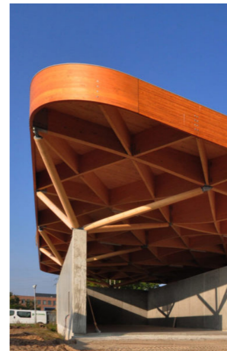
Houten constructie betonnen voet
