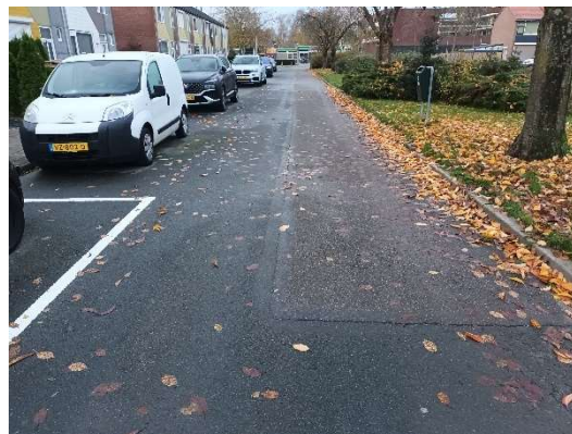
Van Tuylplein met asfalt reparatievak
