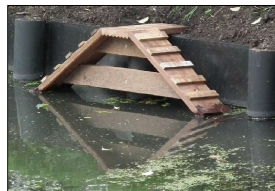
principe fauna-uittredeplaats zie standaarddetail 7WA-03-02
