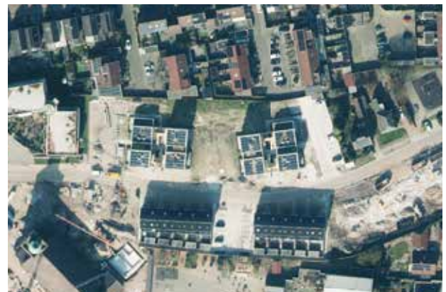
afb.29 Luchtfoto modulaire woningbouw 't Kempke (bron: QGIS)
