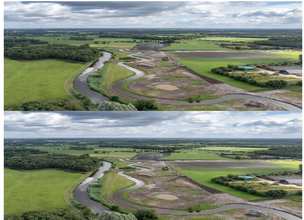
Aanleg nieuwe hoogwatergeul en poelen
