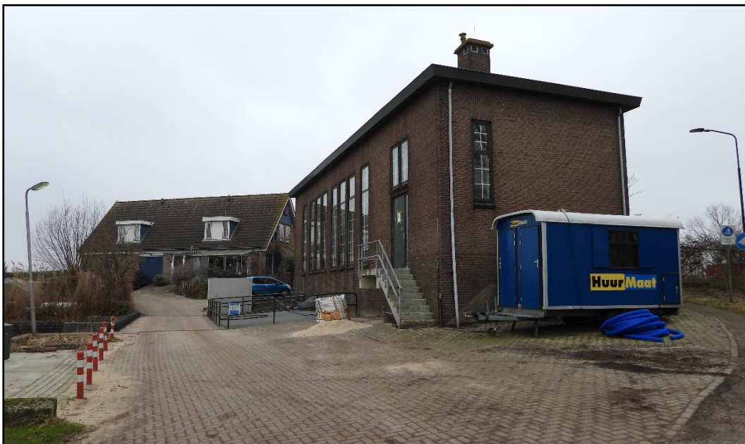
Afbeelding 2. Impressie van Gemaal de Ruiter.
