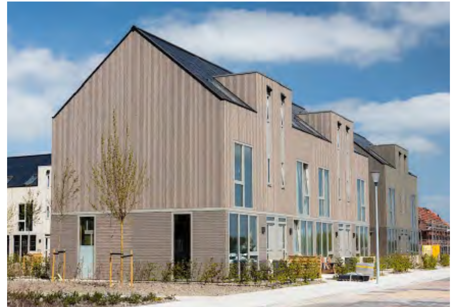
Fabrieksmatig gebouwde rug-aan-rugwoningen van biobased materialen. De woningen hebben een lage milieu-impact en een snelle bouwtijd. Fabrikant: Startblock
