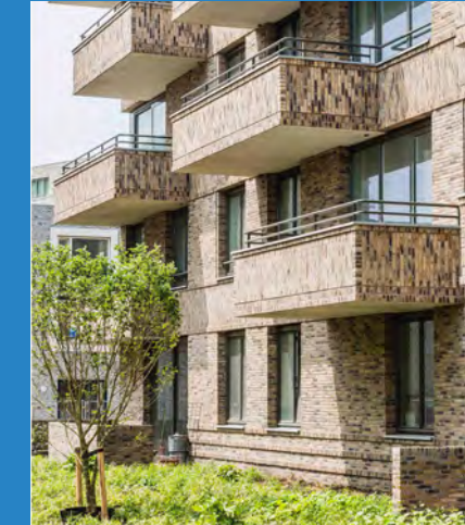
De Zeebonk, Amsterdam - NWA architecten - Zuidgevel veld 1
