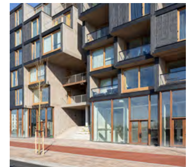
'Juf Nienke' is een voorbeeld van biobased en modulaire bouw met een lage milieu-impact en opslag van CO 2 . Architect: RAU en SeARCH
