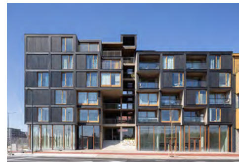
'Juf Nienke' is een voorbeeld van biobased en modulaire bouw met een lage milieu-impact en opslag van CO 2 . Architect: RAU en SeARCH
