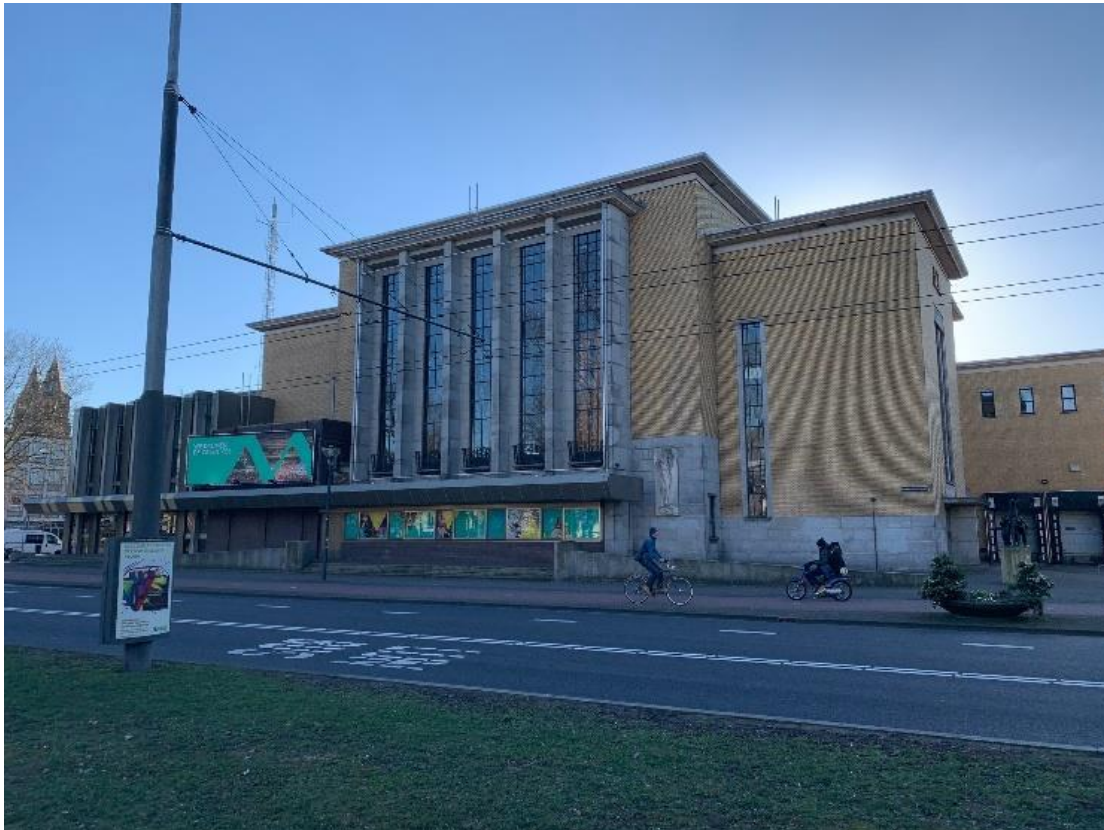
Stadstheater voor de sloopwerkzaamheden
