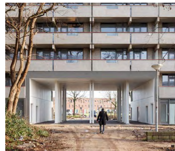
Verbinding door transformatie van de Stroomberg flat
