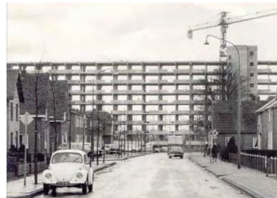
Merlijn flat in aanbouw in 1971, zicht vanuit de Verlengde Parkweg.
