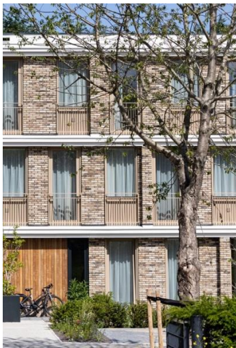
Gelaagd gebouw met verschillende gevelinvullingen
