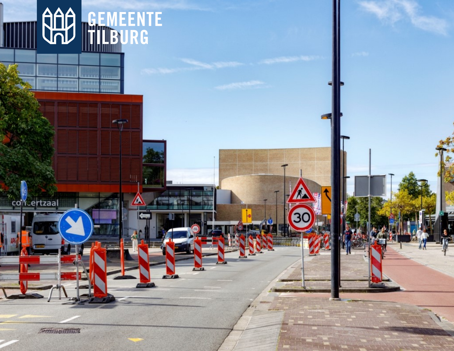
Figuur 1. Overgenomen uit Beeldbank (16891) door Dolph Cantrijn - beeldbank Gemeente Tilburg, 2025. Copyright 2023, Dolph Cantrijn.
