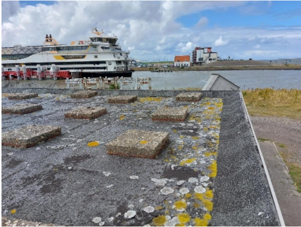
Bitumineuze dakbedekking
