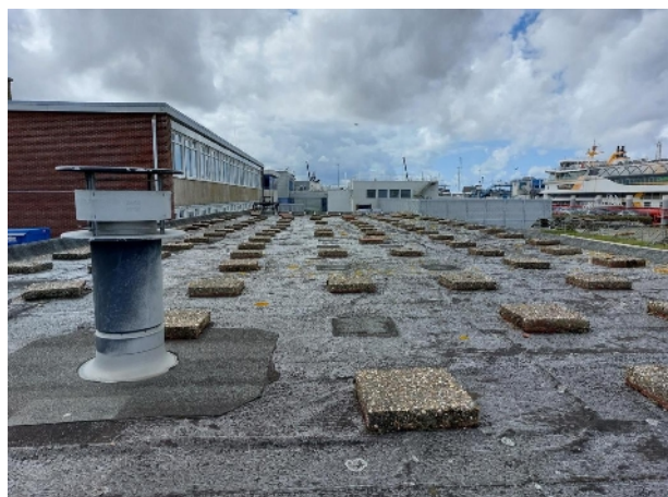
Bitumineuze dakbedekking
