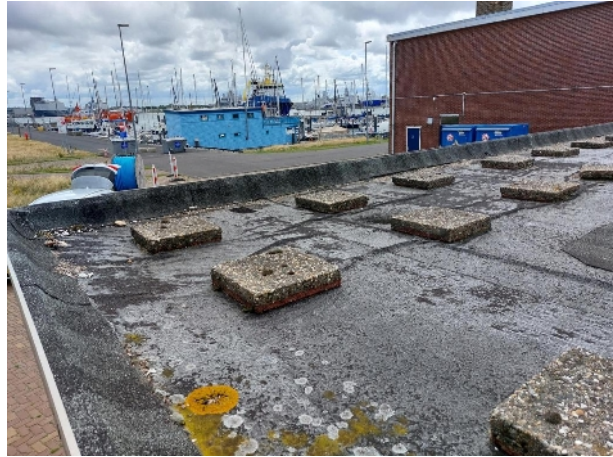
Bitumineuze dakbedekking
