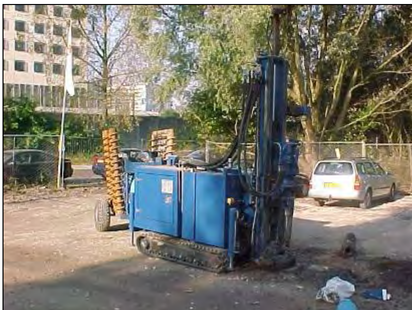
plaatsing van machinale avegaarboringen (boring 903)
