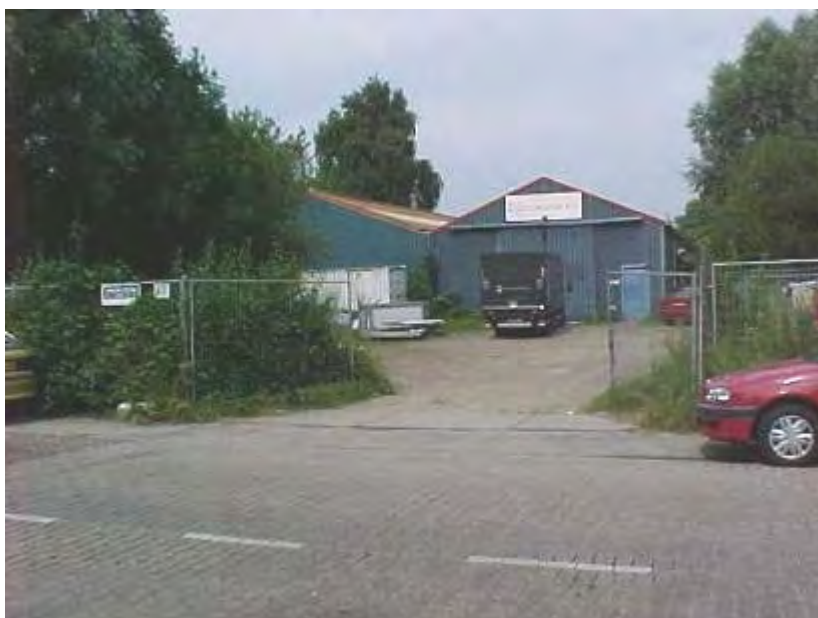
Foto: Duivendrechtsekade 27 en 29, vanaf de H.J.E. Wenckebachweg, Foto augustus 2005
