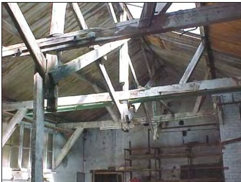
dakconstructie zuidwestelijke gedeelte
