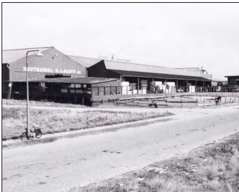
Houthandel Harff, foto 1972 gezien vanaf de Wenkebachweg. De insteekhaven en de sloot ten zuiden van de houthandel zijn reeds gedempt.
