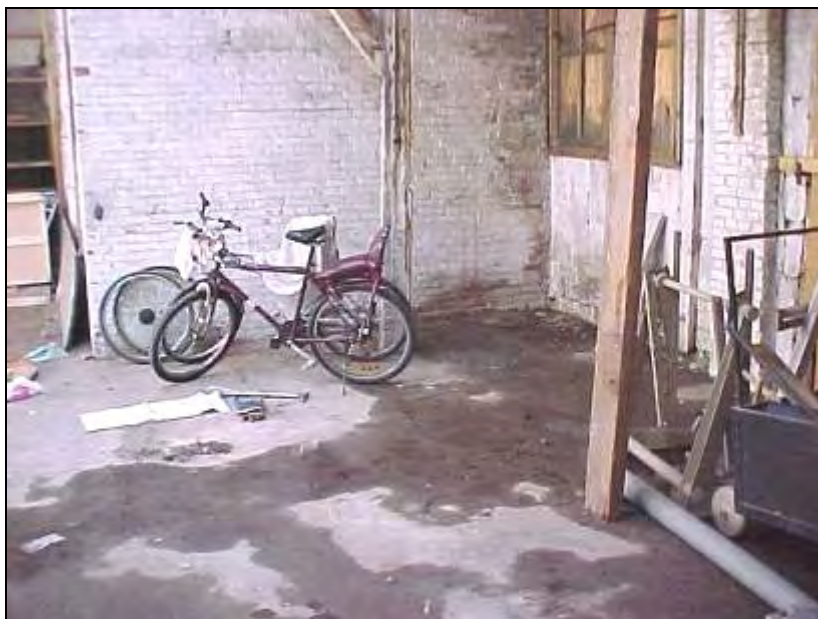
voormalige timmerwerkplaats Heijmi, met zicht op de voormalige GEB-ruimte (achter fietsen).
