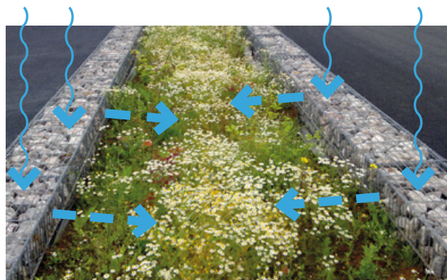
voorbeeld van regenwater retentie
