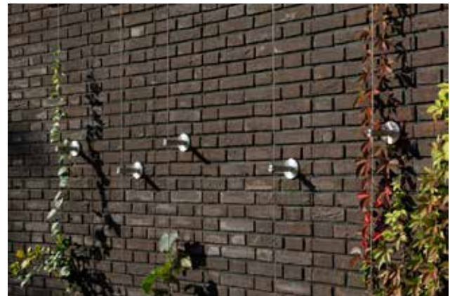
Voorbeeld van de bevestiging van staaldraad aan een gevel t.b.v. windende klimplanten
