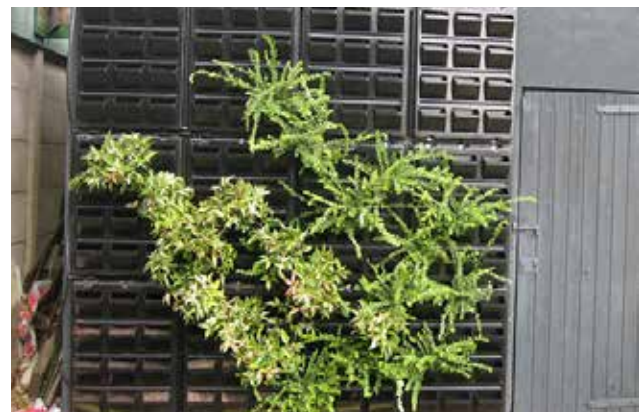
Voorbeeld cassetesysteem t.b.v. een groene gevel. Dit voorbeeld voldoet niet aan de welstandscriteria dat de gevels ook aantrekkelijk zijn als de beplanting niet of beperkt groeit.
