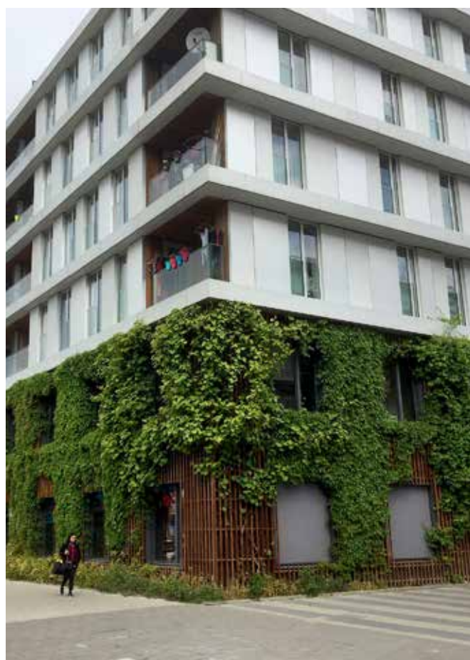
Groene sokkel: geveltuint en gevel voorbereid op klimplanten
