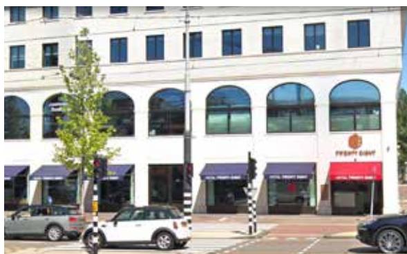
Deel van sokkel onder opbouw als een markant voetstuk, bijzondere openingen
