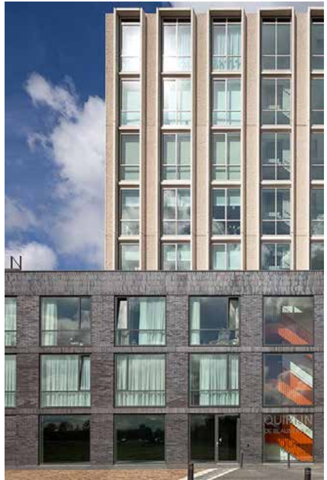
Links: voorbeelden van opbouwen die op verschillende manieren een architectonische eenheid vormen met de sokkel.
