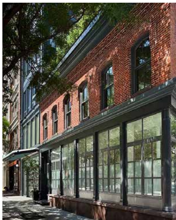
Levendige, gedifferentieerde straatwand, ook in gebouwdelen van 8m hoog
