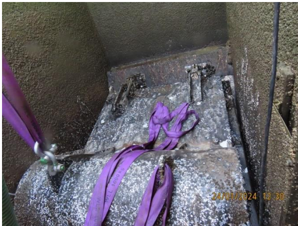
Figuur 33: Overzicht terugslagklep in uitstroomconstructie.
