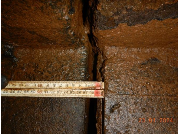
Figuur 31: Voegbreedte dilatatievoeg.
