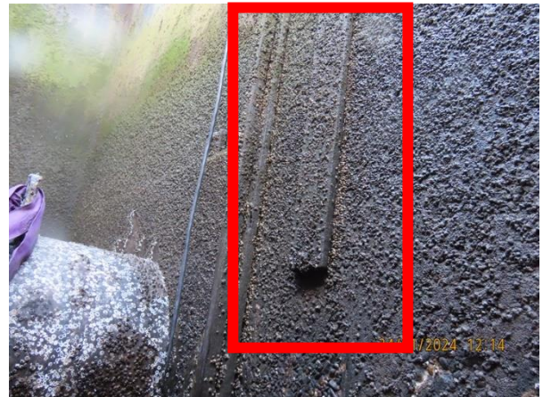
Figuur 34: Overzicht (losse)planken uitstroomconstructie.
