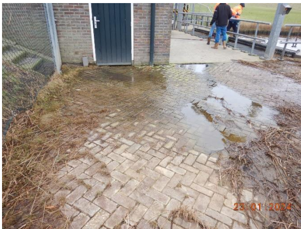
Figuur 21: Plaspvorming noordzijde pomphuis.
