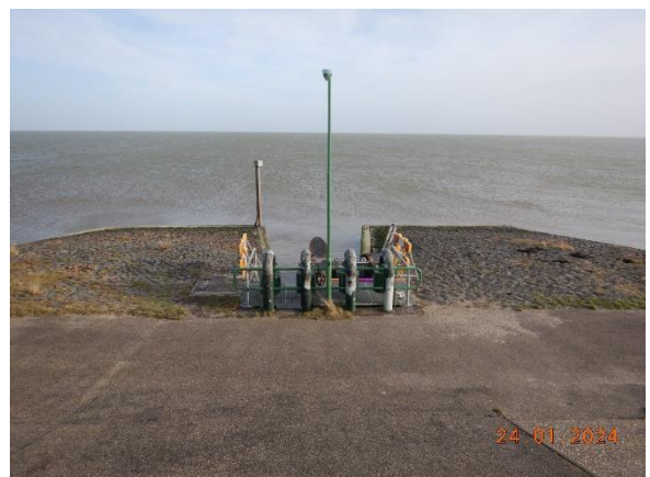
Figuur 5: Aanzicht uitstroomconstructie.
