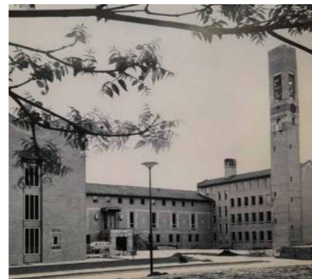
De vrijstaand geplaatste toren domineert het beeld van de binnenhof
