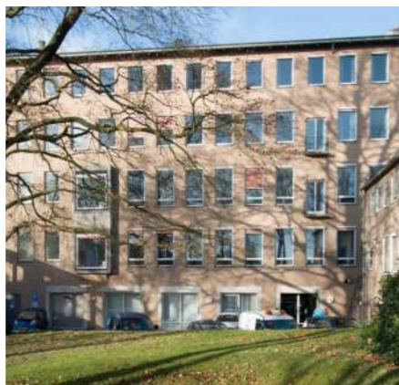
De kelder van de oostelijke gevel is bereikbaar vanaf de buitenzijde
