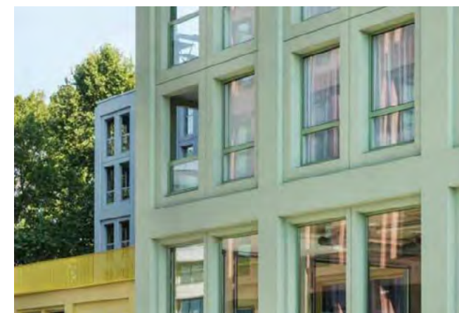
Ook terugliggingen en doorkijkjes, niet alles is een wand.
