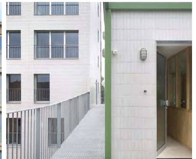
Nette detaillering van de buitenontsluiting.
