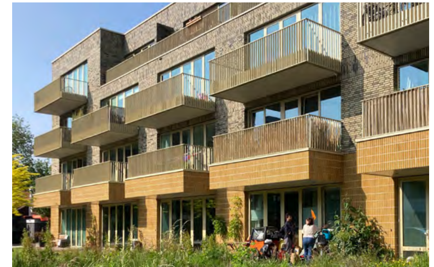
Beton wordt aan het zicht onttrokken door materialen die wel mooi verouderen.
