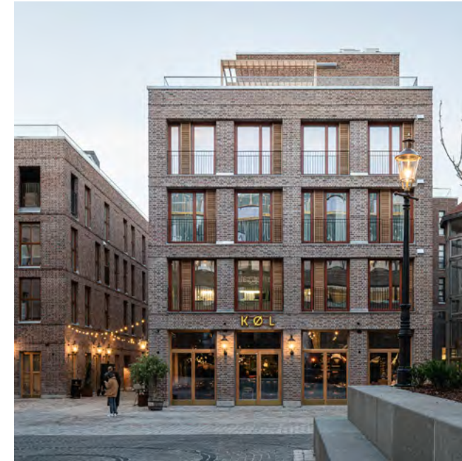
Houten kozijnen in de winkelplint.
