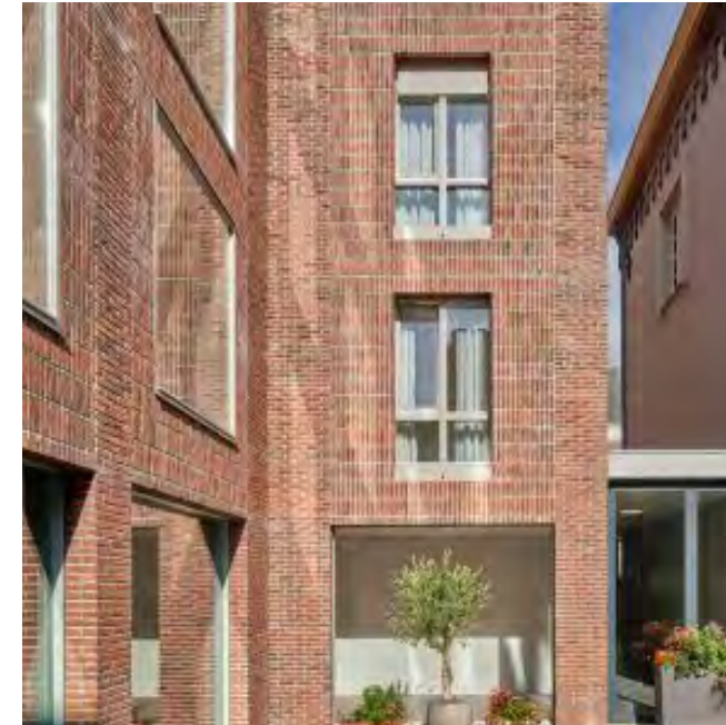
Gevelopeningen met verschillende dieptes.
