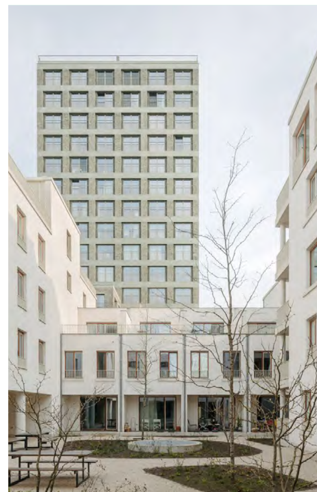
Stadswoningen met een setback en terras met daarachter een toren met een abstracter uiterlijk.
