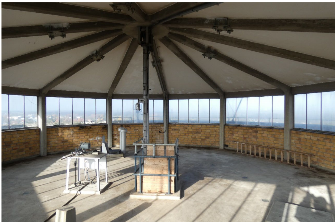
Afb. 62. Overzicht van de ruimte in de lantaarn boven het waterreservoir met de betonnen kniespanen voor het dragen van het twaalfvormige tentdak.
