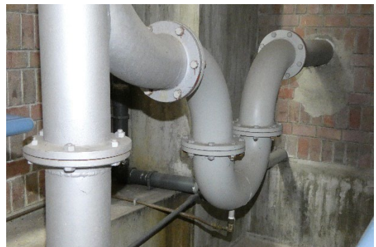
Afb. 72. Van de schoondrinkwaterleiding gaat een extra leiding bovengronds door de gevel heen naar buiten. De functie van deze aftakking is (nog) niet bekend. Mogelijk betrof het een aan de buitenzijde van de drinkwatertoren bovengrondse aansluiting voor het kunnen vullen van tankauto's met drinkwater, of een aansluiting voor een blusleiding.
