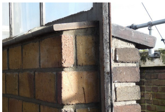
Afb. 54. Detail van het binnen- en buitenmetselwerk bij de toegang naar de omloop van de lantaarn.
