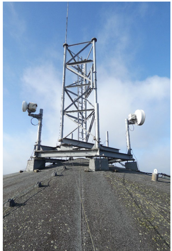
Afb. 30. In 2000 is deze antenne-installatie met een ijzeren frame en steunvoeten op het dak geplaatst.
