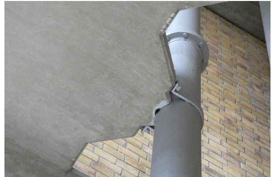
Afb. 70. Detail montage van de standleidingen aan de betonnen vloeren.
