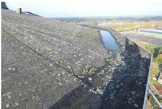
Afb. 57. De bitumineuze dakbedekking op het twaalfhoekige tentdak loopt door tot in de goot en is met een aluminium daktrim afgewerkt.
