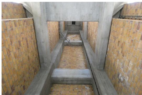
Afb. 73. De steens gevels zijn aan de binnenzijde beklampt met een geel genuanceerde klinker.
