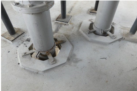
Afb. 69. Detail van de vloerdoorvoeren van de beide standleidingen op de lekzolder.
