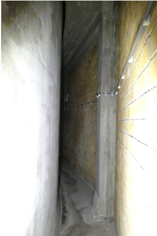
Afb. 77. De ruimte tussen het waterreservoir en de ommetseling (gevel). Het gaat om de geel gemarkeerde vlakken in Afb. 75.
