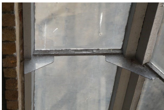
Afb. 53. De hoge verticale vensterstroken bestaan uit gekoppelde stalen raamkozijnen die op de hoeken zijn versterkt met aangelast plaatijzer voor het opvangen van de windbelasting.
