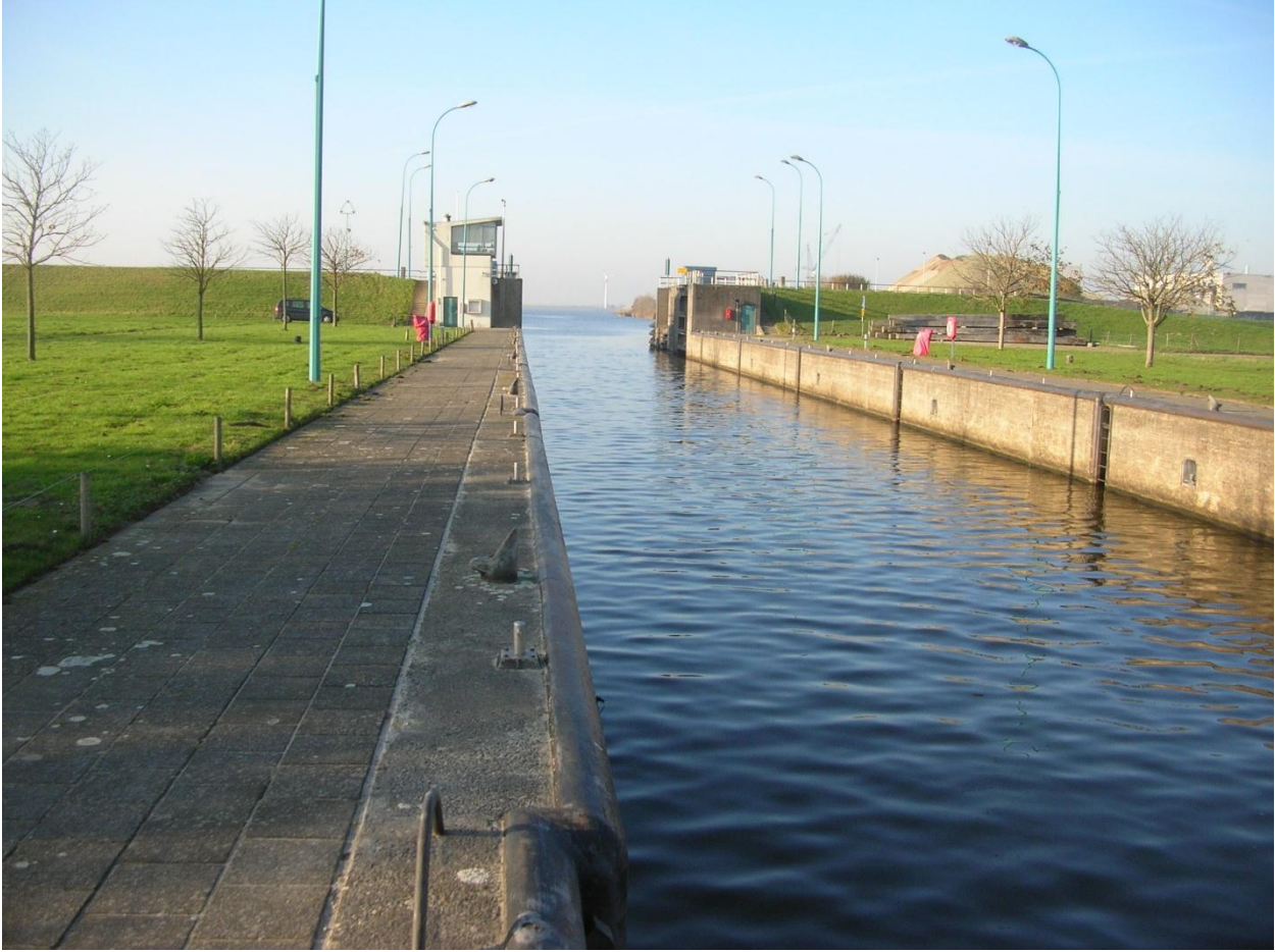
Dintelsas Schutsluis (Manderssluis)
