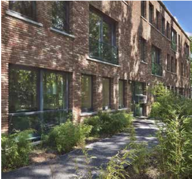
Woningen op de begane grond hebben voldoende privacy
