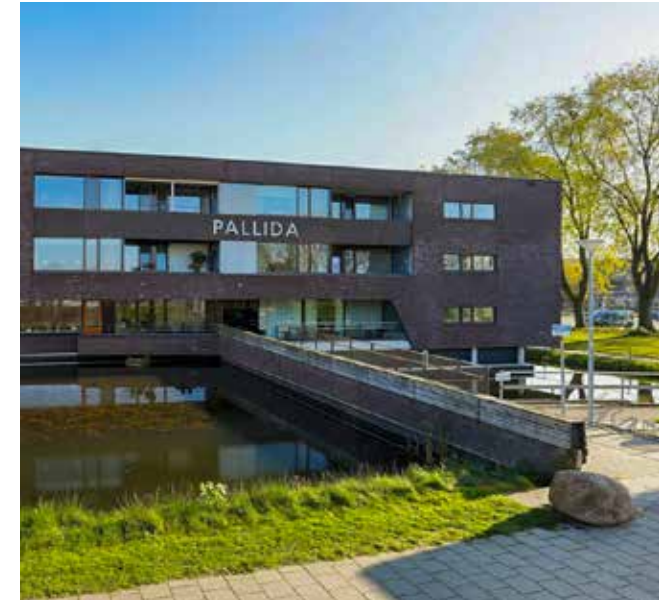
B | Bestaande bebouwing (Pallida) - Karbeel
