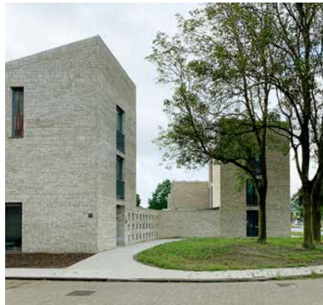
D | Bestaande bebouwing (Heldenhof) - Van Schaikweg
