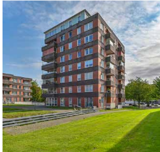
A | Bestaande bebouwing - Karbeel
