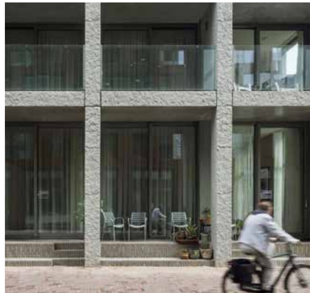
Privé buitenruimtes op begane grond als onderdeel van de architectuur
