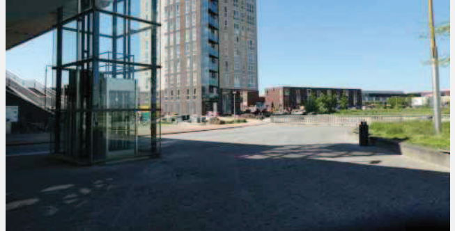
10 laagse nieuwbouw toren aan het zuidwestelijke kwadrant
