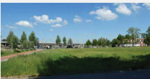
Zicht vanuit De Laar naar het spoorviaduct
