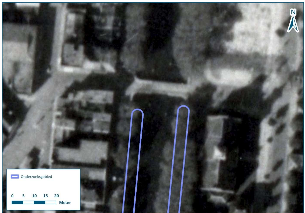
Figuur 7 Brug over het Helder's Kanaal ter hoogte van het Nieuwe Kerkplein in 1944
