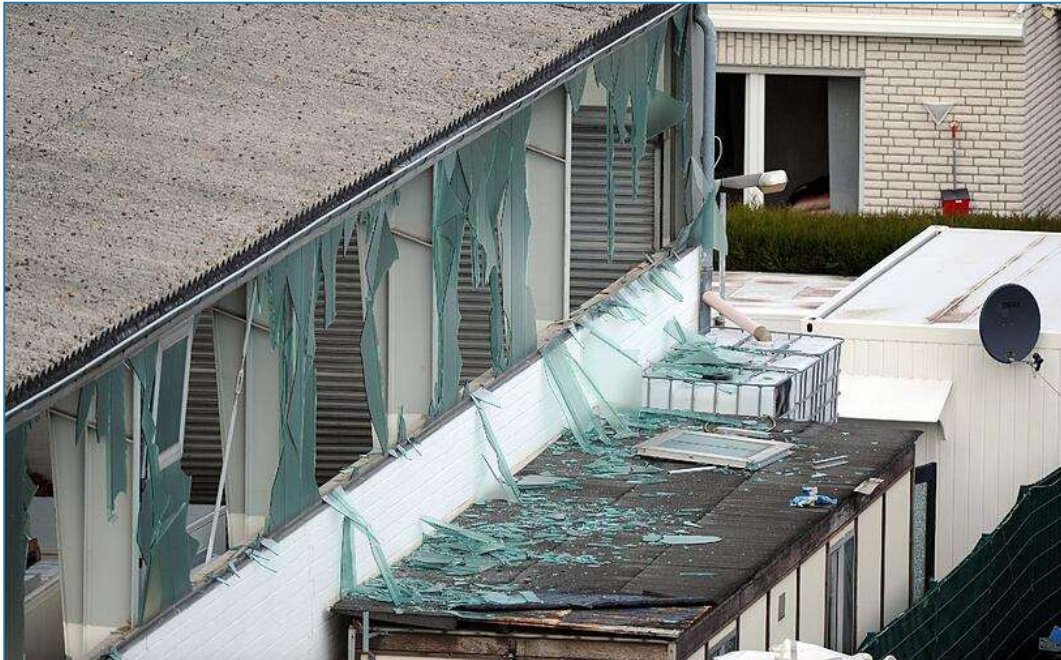
Figuur 20. Een schokgolf kan op honderden meters afstand schade en letsel veroorzaken door overige fragmenten zoals glasscherven. Deze schade werd veroorzaakt door de schokgolf van een ontplofte vliegtuigbom bij sloopwerkzaamheden. (bron: DPA)
