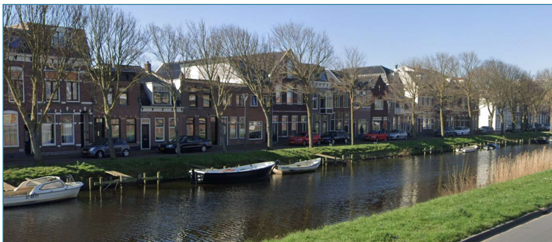
Figuur 13 Houten aanlegsteigers langs de Loodsgracht
