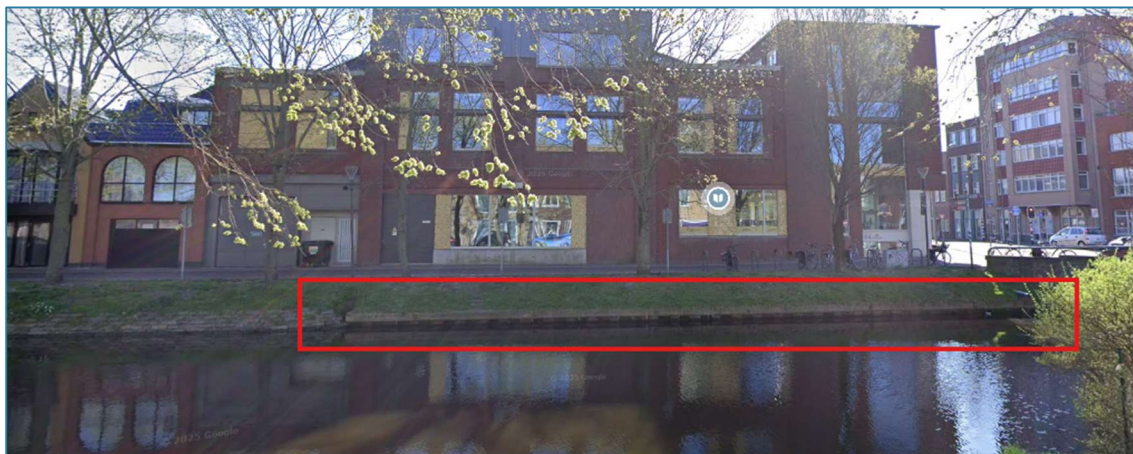
Figuur 12 Damwand langs de Keizersgracht ter hoogte van de Beatrixstraat
