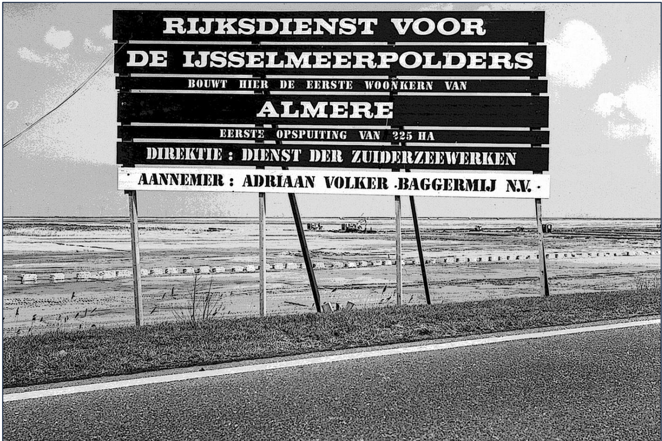
Figuur 2: Start eerste woonkern van Almere onder directie van Diest der Zuiderzeewerken, 29 maart 1973. Bron: Wolffram, Dirk. 70 jaar Ingenieurskunst, Dienst der Zuiderzeewerken 1919-1989, (Lelystad: 1997).
