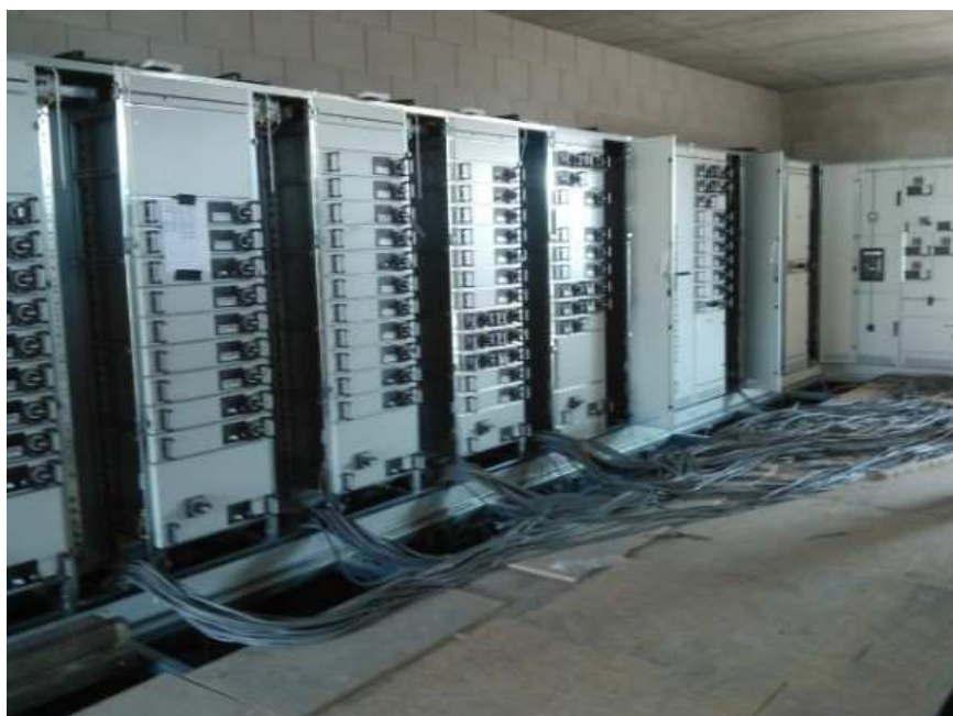
Fig. 14-1: Het verwerven van een MCC op RWZI Den Helder (2015).
