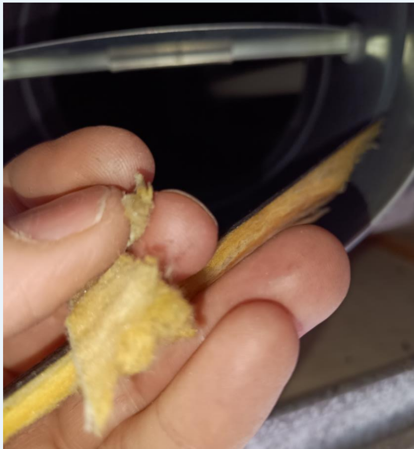
figuur 1: Interne isolatie gevonden op verschillende plekken in de toevoerventilatie.
