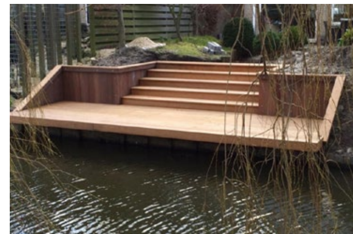
Voorbeeld uitvoering vlonder: aan weerszijden blijft minimaal 0,50 meter vrij tot aan erfgrans
