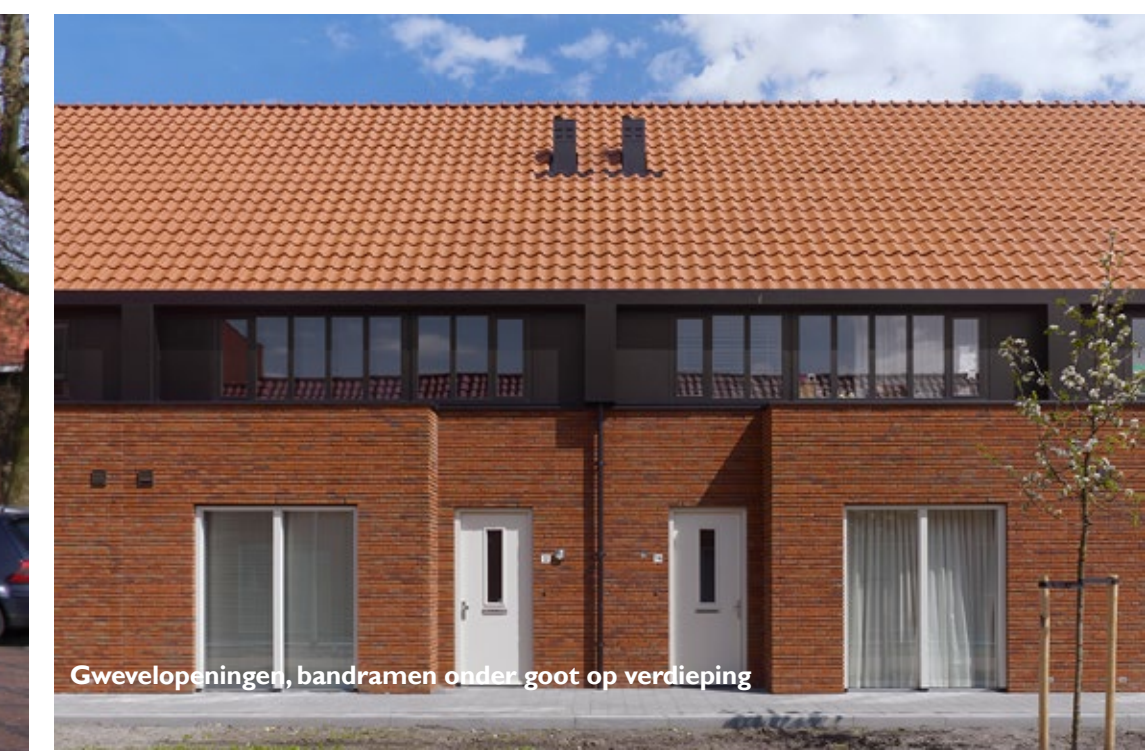
Ensemblewerking, bandramen onder goot op verdieping, omtimmerde goot, schoorsteen
