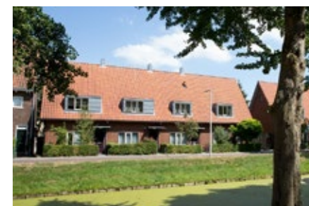
één bouwlaag met langskap, hagen en geschakelde ramen in de dakkapel
