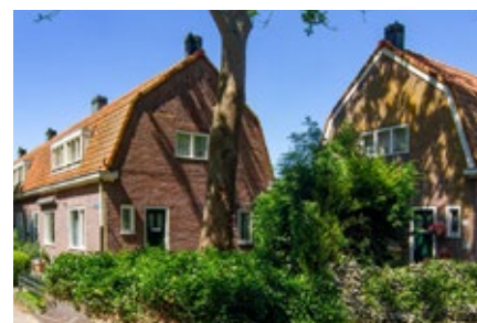
Mansardekap, schakeling van ramen - ook in de dakkapel
