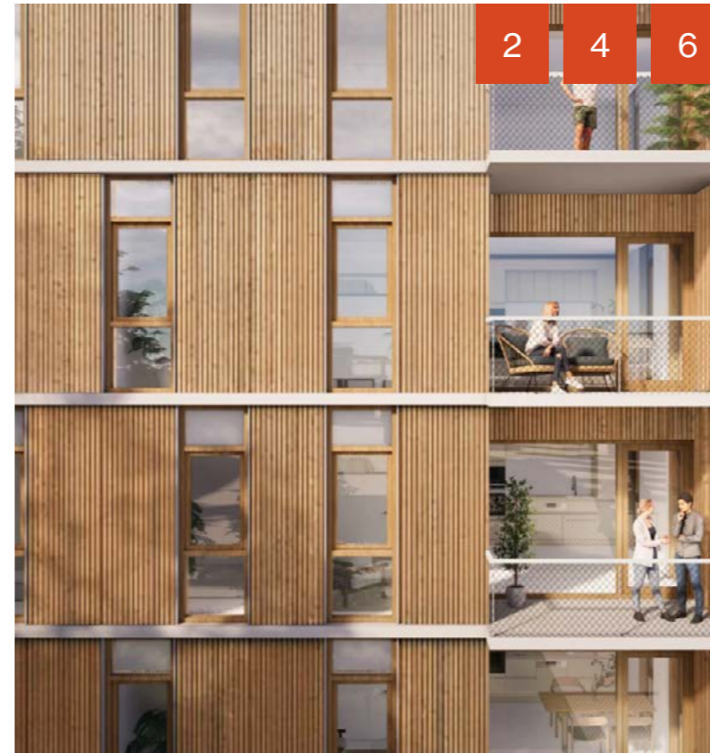
Houten gevelafwerking van appartementenblokken; horizontale geleiding in de gevel; balkons met <1 meter uitkraging. Beeld Paul de Ruiter Architects
