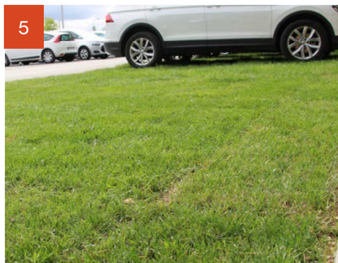
De parkeerplaatsen in de parkeerkoffer bieden maximale waterinfiltratie
