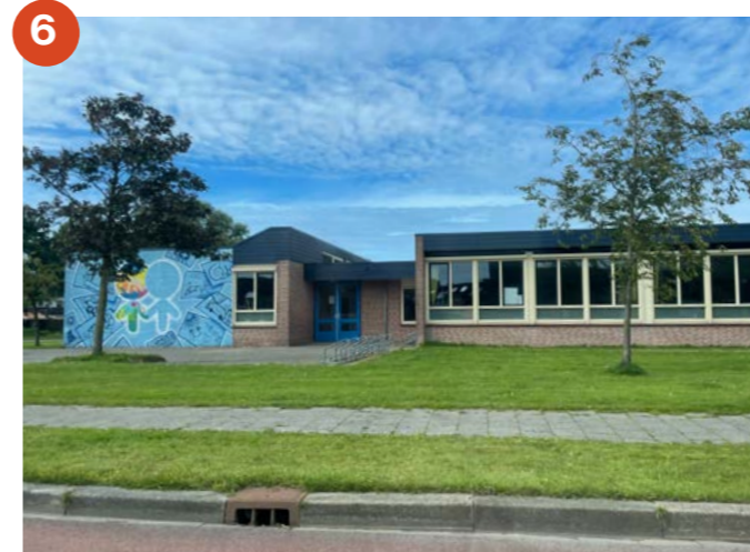
6 De school bestaat nu uit een en tweelaagse bouwdelen met veel ramen
