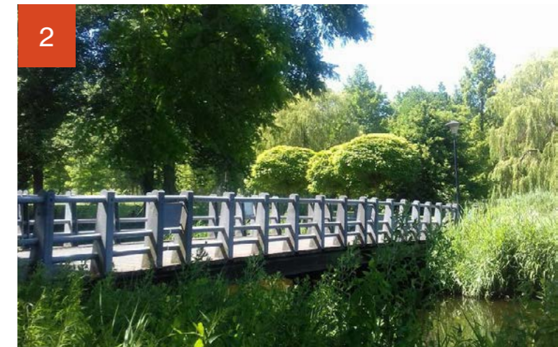
Bestaande brug in park de Groene Wiecken
