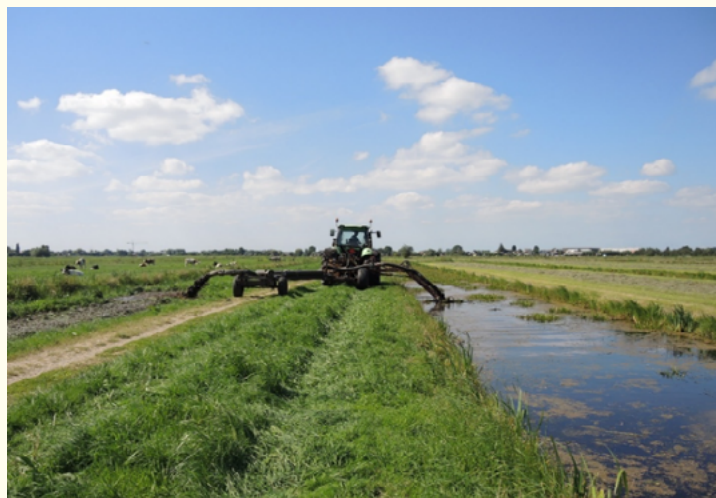
Baggeren met de baggerpomp.
