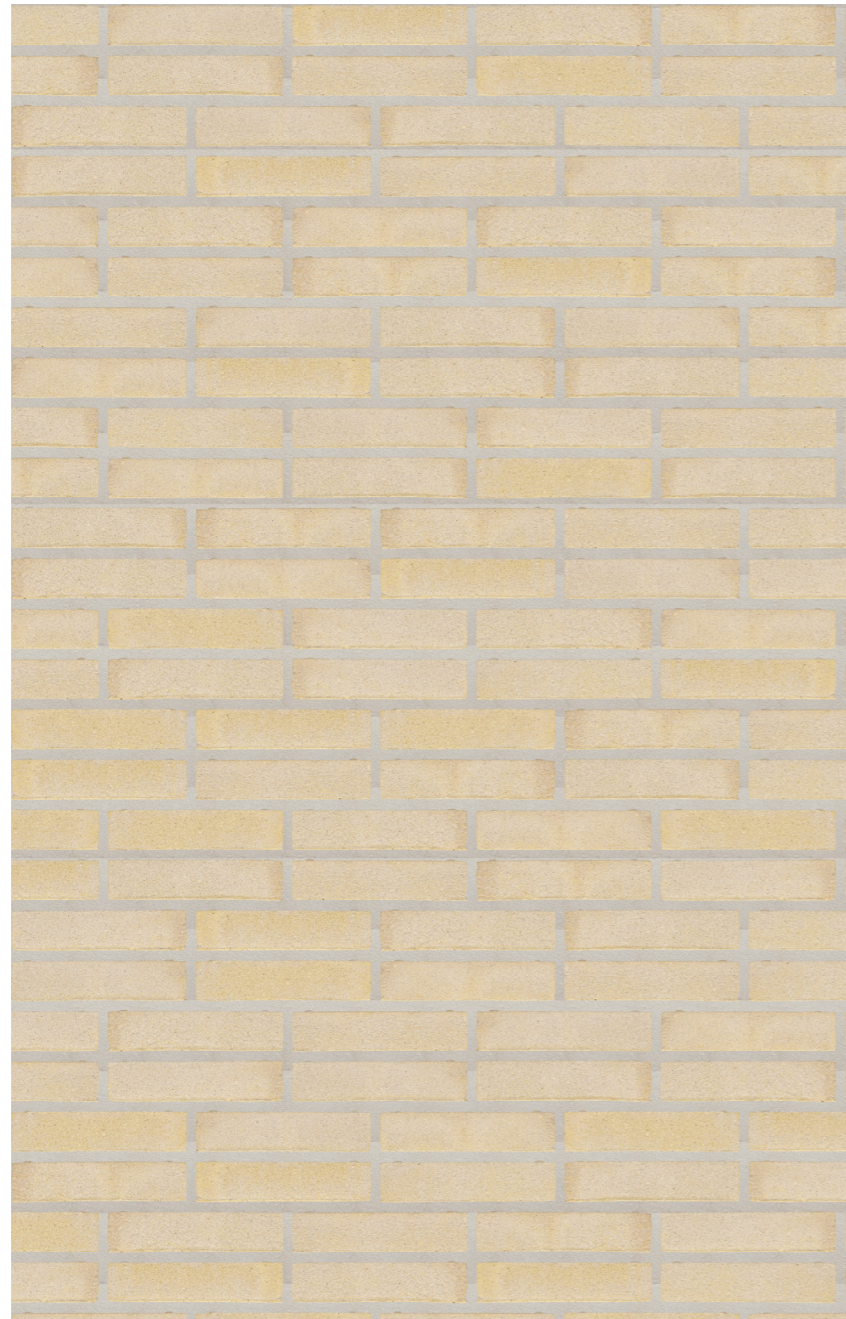
lichtgele zanderige stenen in blokverband
