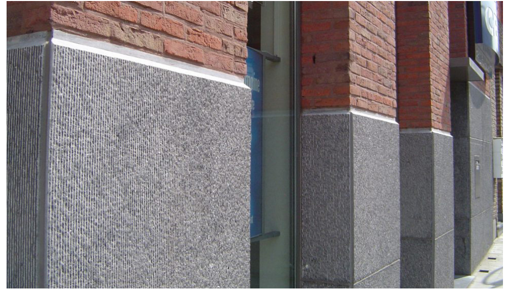
Voorbeeld: plint met gevellint van hardsteen, rood baksteen met diepe negge | Pierre Bleue Belge
