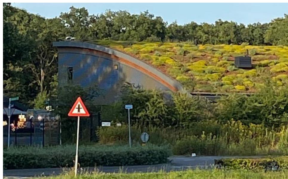
Voorbeeld: tondak met duidelijke dakrand | gemeentewerf, Eersel
