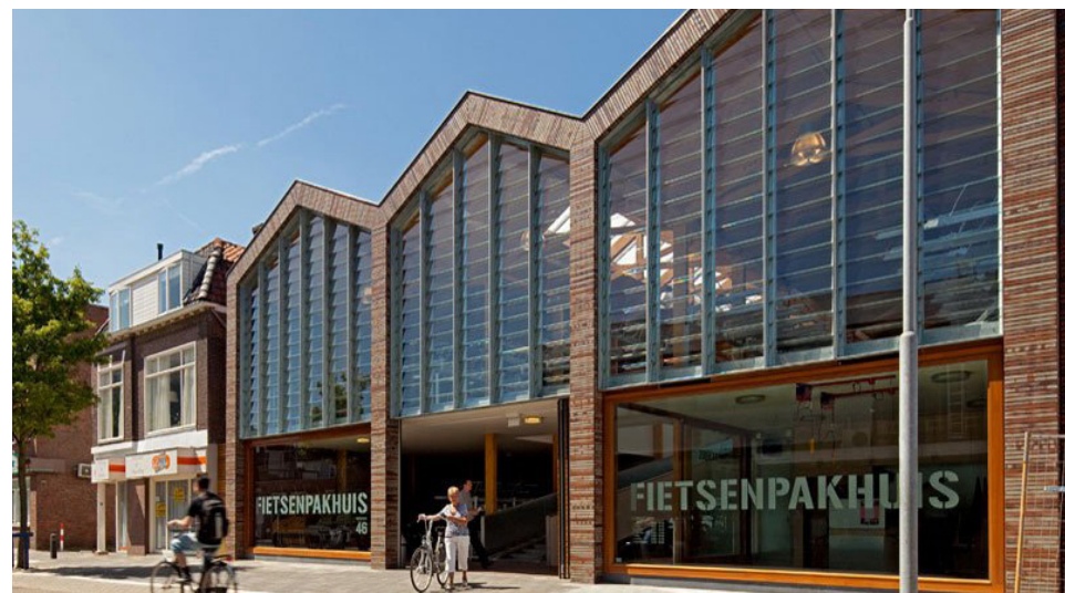
Voorbeeld: kleinere korrel, menselijke maat, transparante plint, grote openingen in de gevel | Fietspakhuis Zaandam
