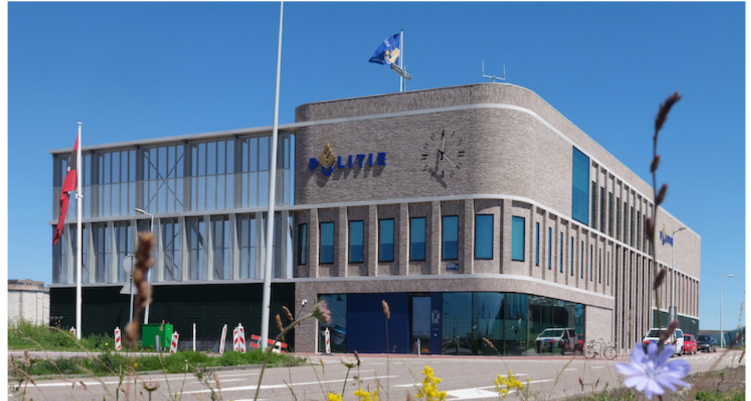
Voorbeeld: bakstenen gevel met open plint en gevel beëindiging | Politiebureau op de Bedrijvenstrook | ontwerp architectenbureau De Twee Snoeken
