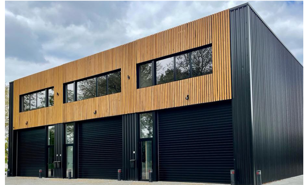
Geprofileerde metalen gevelplaat, gebruikt in twee richtingen, met houtaccenten, waardoor een interessante geleiding en differentiatie van de gevel ontstaat
