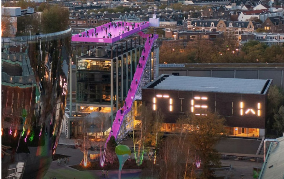
26 Voorbeeld: openbaar toegankelijk dak van Post Rotterdam | ontwerp UNStudio
