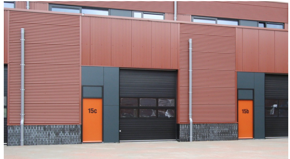
Voorbeeld: combinatie bakstenen lint en verschillende plaatmaterialen | Penta verzamelgebouw | Amsterdam-Noord
