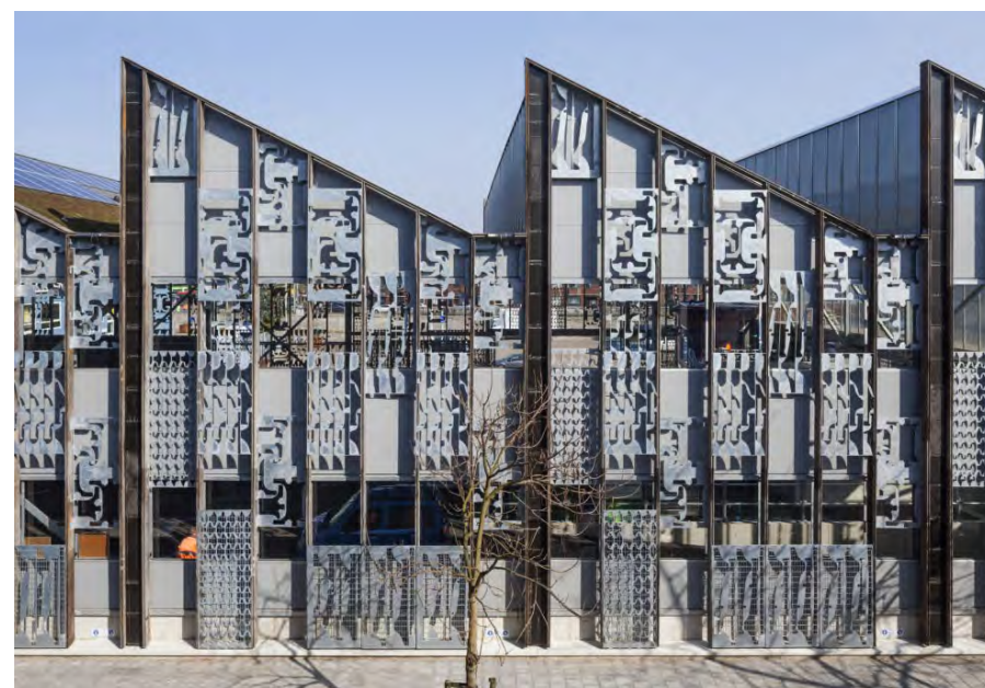
Afvalpunt in Den Haag waar gebruikt gemaakt is van restmaterialen als gevelbekleding
