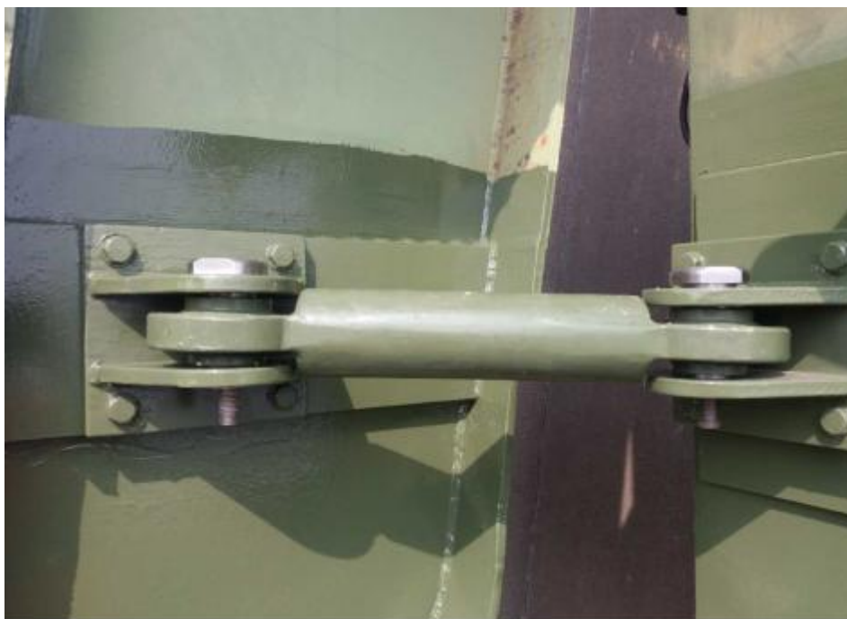
Afbeelding 5A.3:: Voorbeeld vastzetinrichting, in dit geval voor een ophaalbrug.
