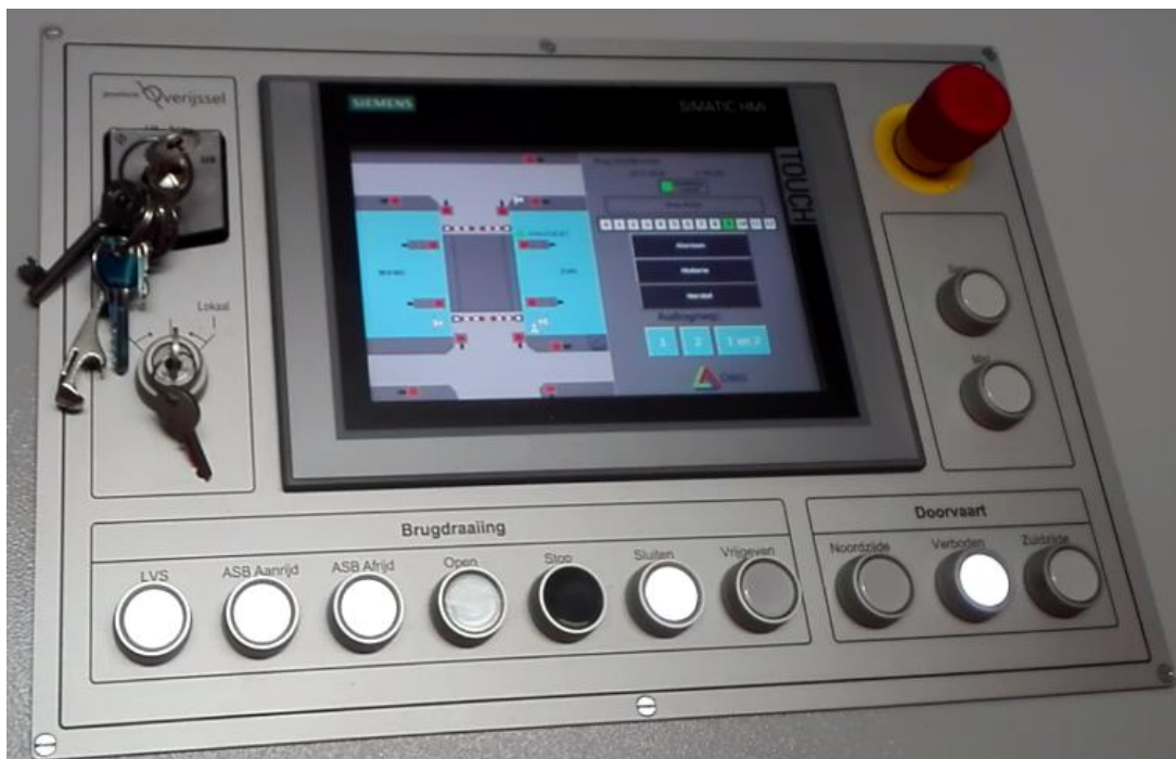
Afbeelding 13.5: Voorbeeld drukknoppenpaneel bedieningslessenaar
