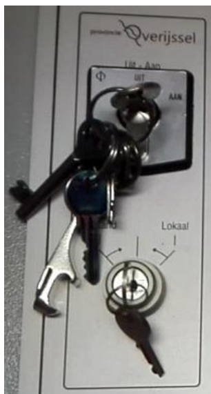
Abbeelding 13.11: Voorbeeld sleutelschakelaars bedieningslessenaar
