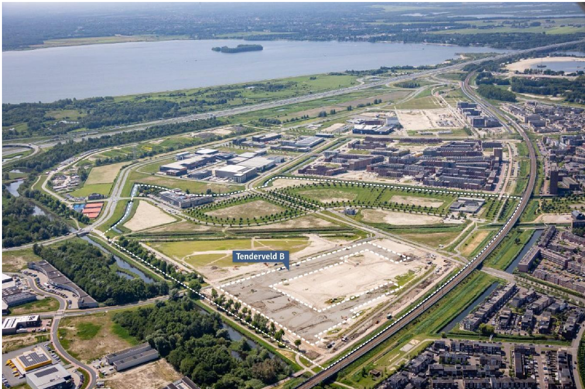
Foto: Luchtfoto's Top-Shot.nl
