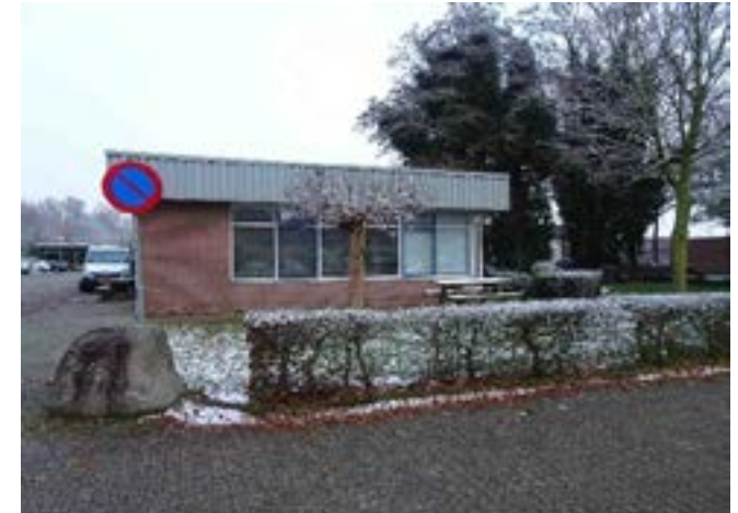
2. Zuidgevel hoofdgebouw met voortuin
