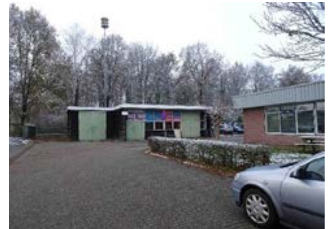
4. Werkplaats met links de calamiteitenroute
