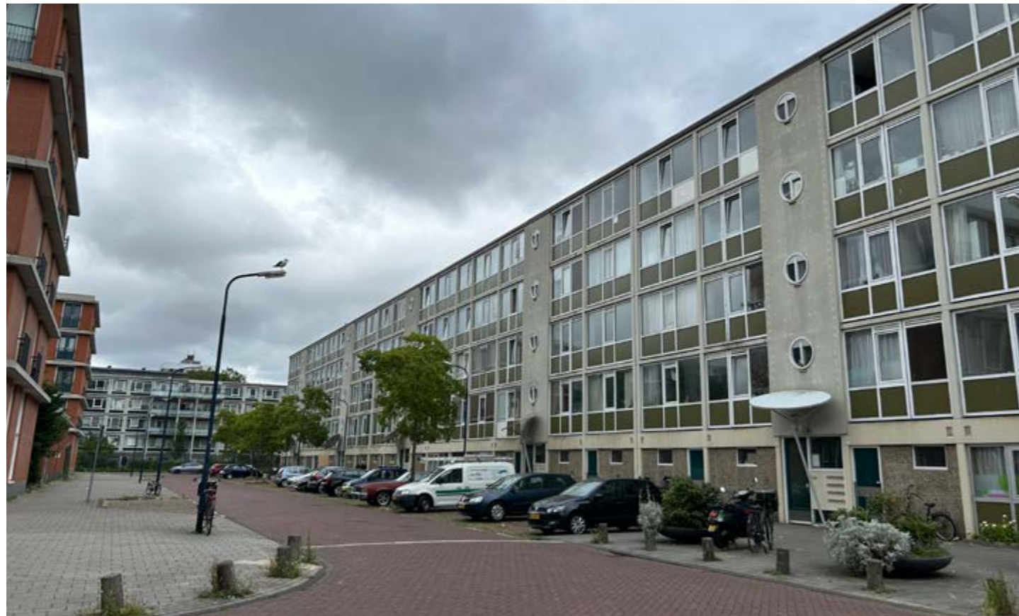
afb 2: het Nierkerke complex voor de sloop
