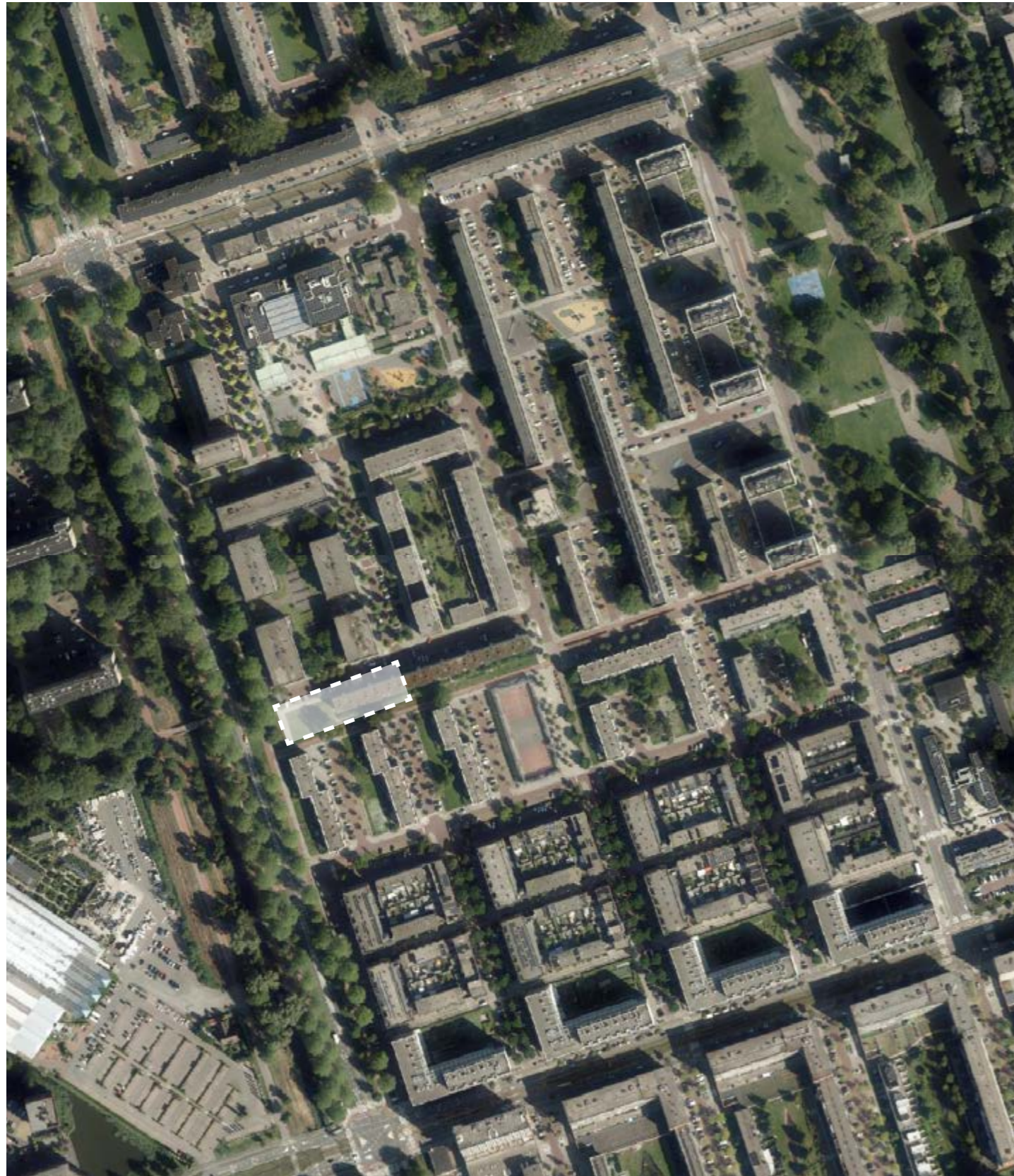
afb 1: luchtfoto met locatie van blok 2.
