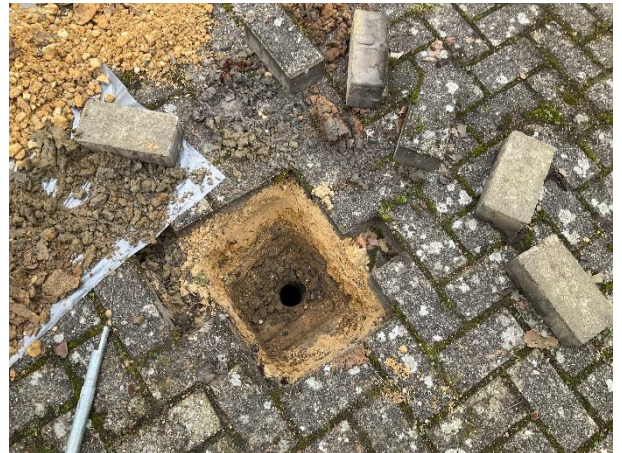
Foto 4 Asbestinspectiegat 9
