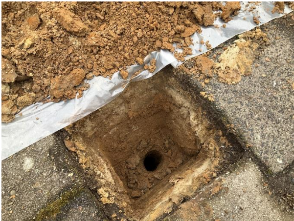
Foto 3 Asbestinspectiegat 6
