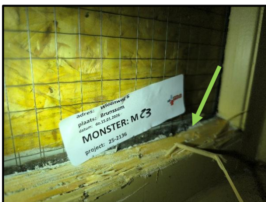
M23 – stopverf is niet asbesthoudend.
