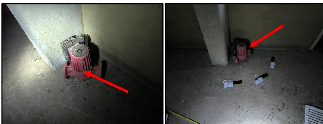
Bron 1.1: oude pomp met resten asbesthoudende pakking in de cv-ruimte.
