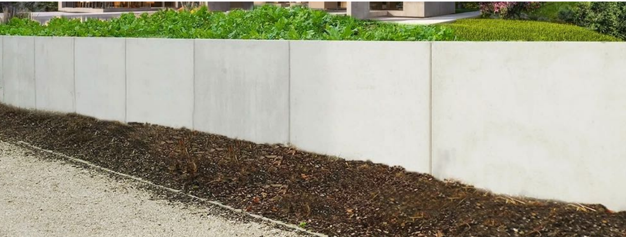
6. Keerwand, prefab beton L-elementen, ruw afgewerkt
