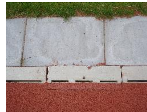
Prefab sportgoten zonder afdekking
