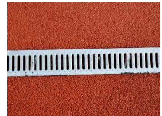
Prefab sportgoot met metalen afdekking
