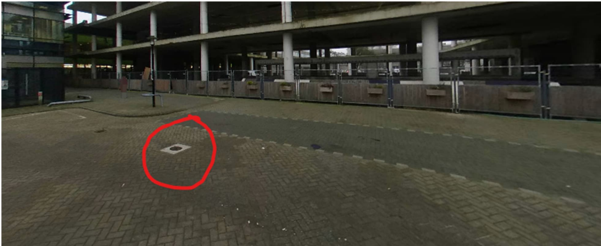
Op foto 4.4.1. de brandhydrant put aan de Budapestlaan
