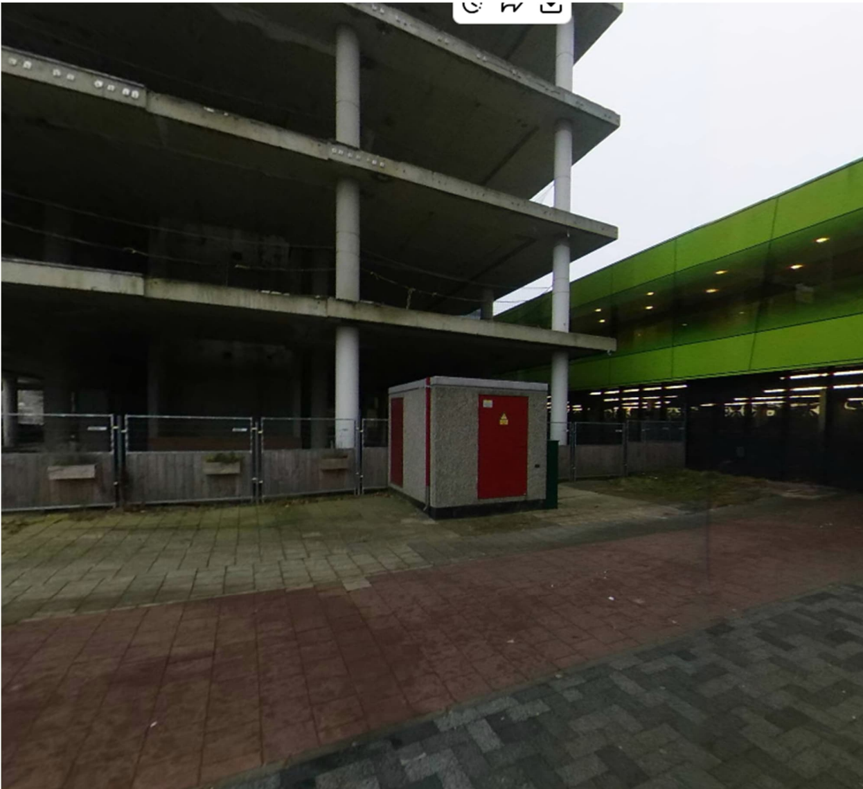
Op foto 4.5.1. de brandhydrant put aan de Budapestlaan
