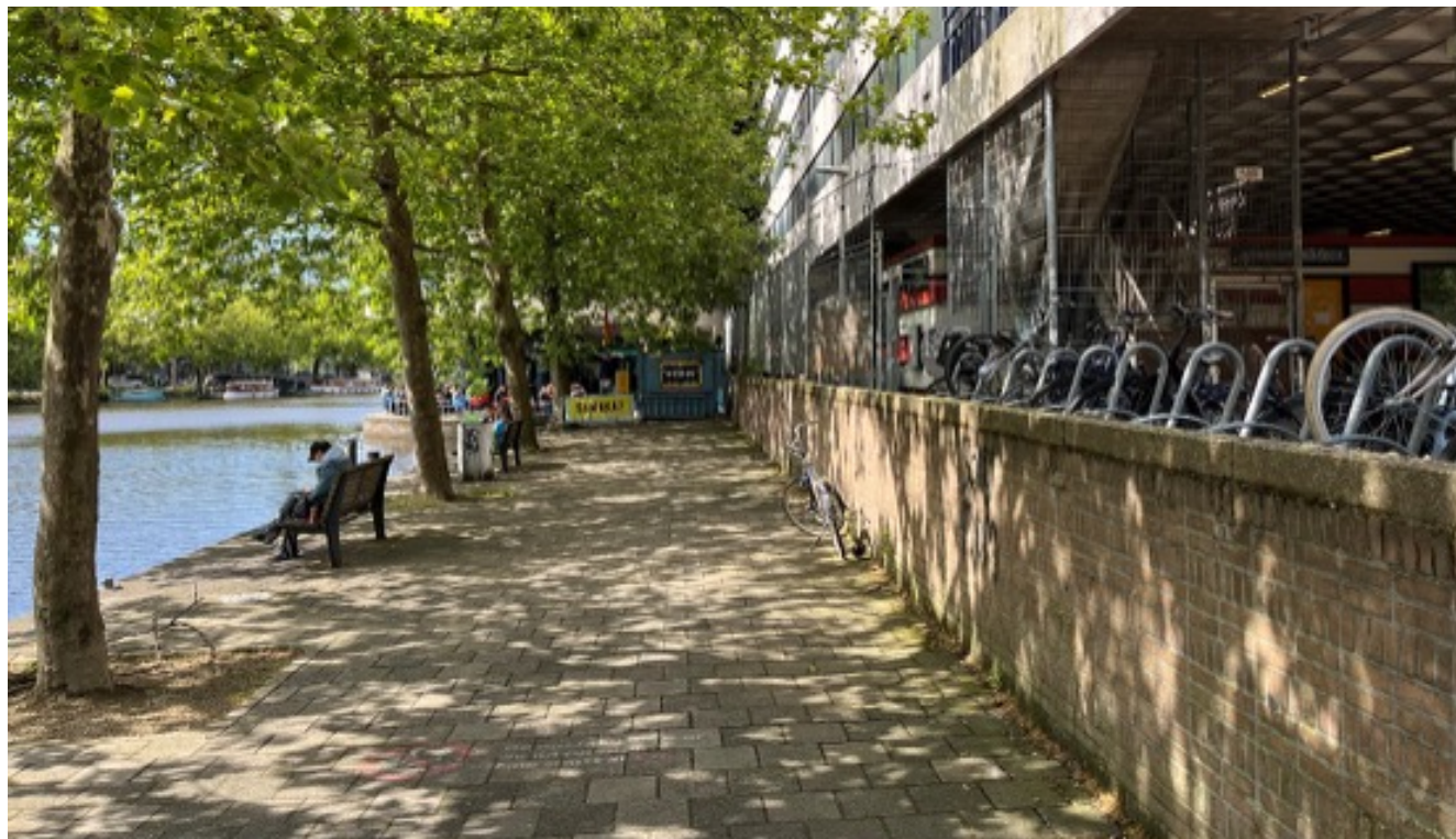
Huidige situatie met keermuur. De keermuur bij het garagegebouw scheidt het hoge en lage deel; de bestrating op de lage kade voldoet niet aan het Puccini-handboek.
