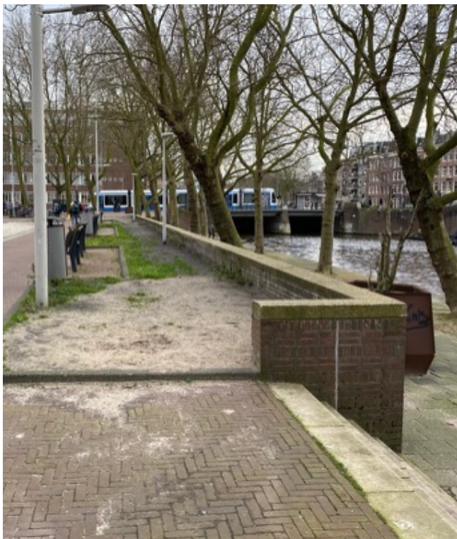
Huidige situatie met keermuur. De keermuur belemmert nu zowel het zicht vanaf het plein op de lagere kade als de verbinding met het water.
