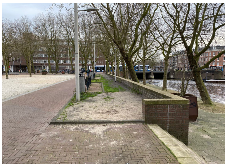
Huidige keermuur tussen hoger gelegen plein en lage kade aan het water
