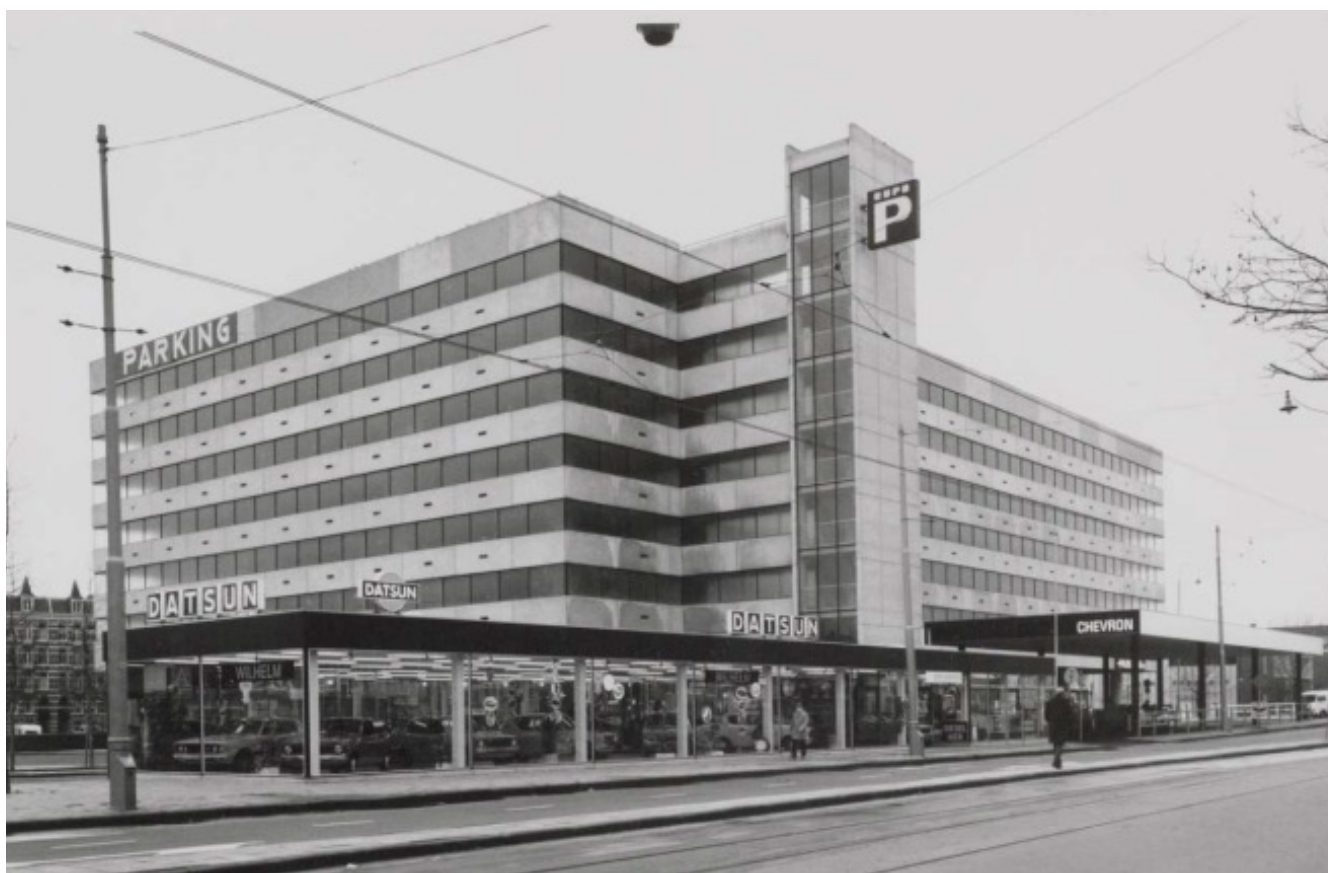
De Europarking gezien vanaf de Marnixstraat, in oorspronkelijke toestand
